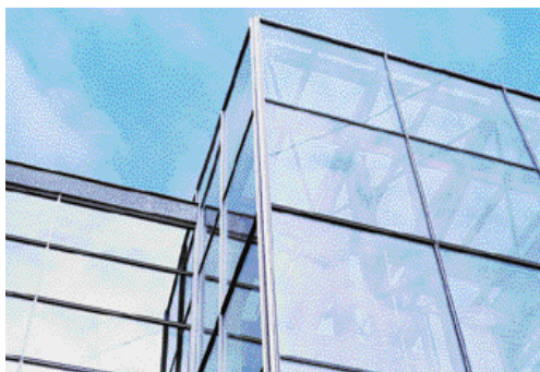
Первое в России применение системы Schuco FW 50 + сталь. Москва, Б. Путинковский пер., д. 3 (м. Пушкинская), КРЦ «Типография»
